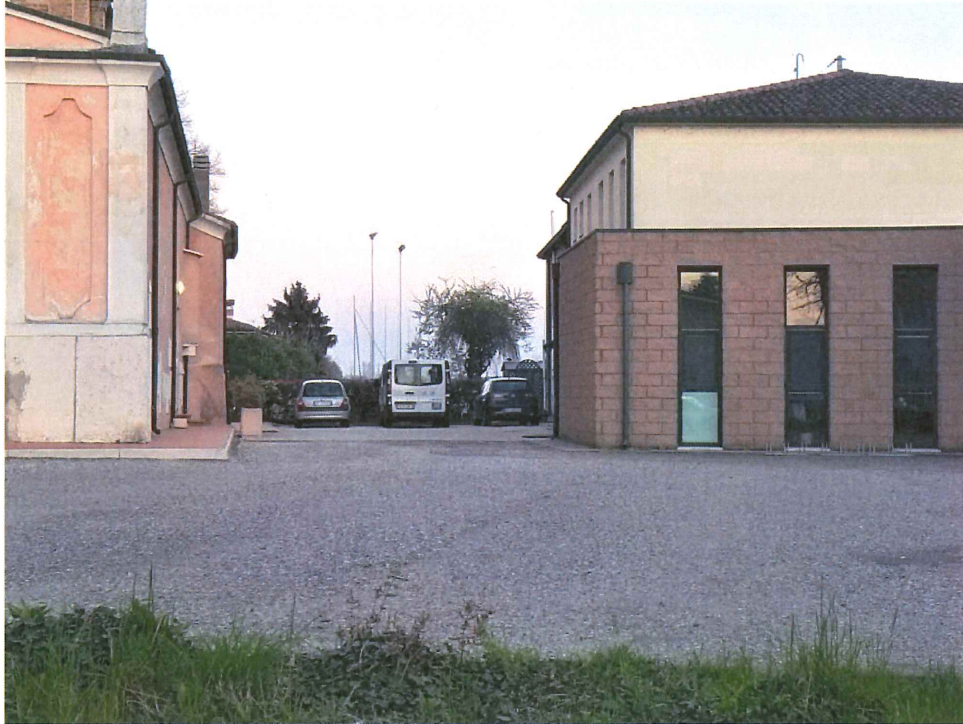
1- Vista dell'area oggetto di interesse da via Chiesa
