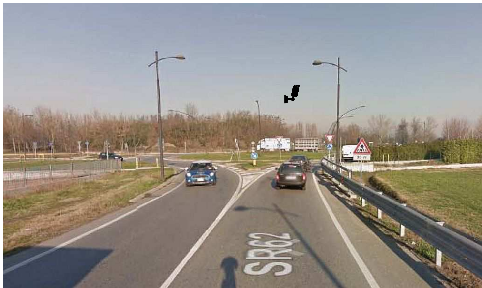
Figura 4 – Installazione della postazione TLC05 su supporto dedicato
