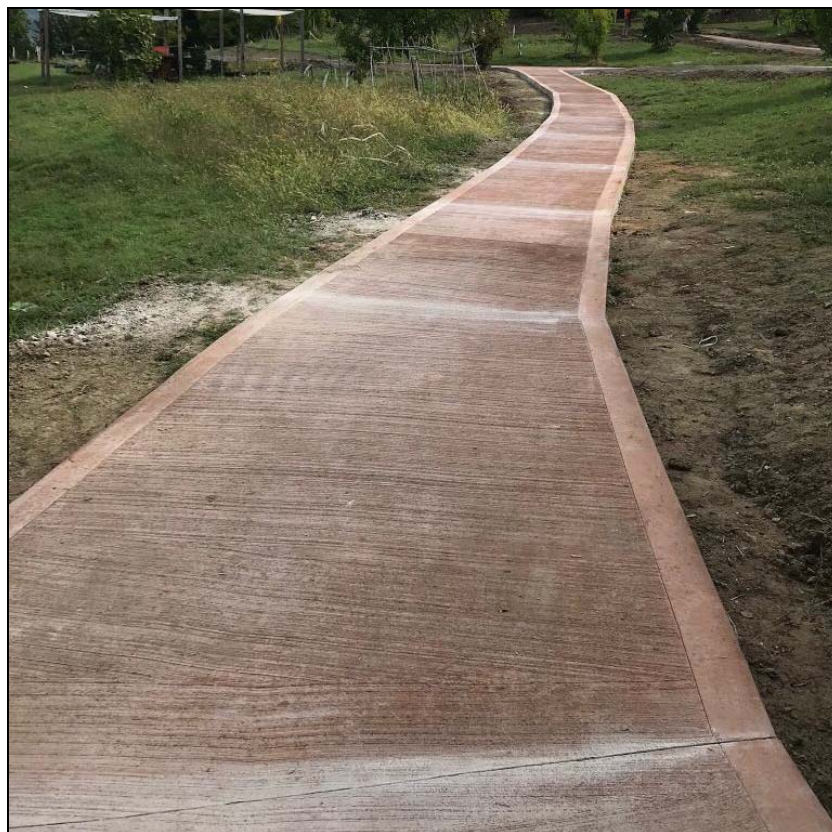
Esempio tipologico di pavimentazione in calcestruzzo colorato
