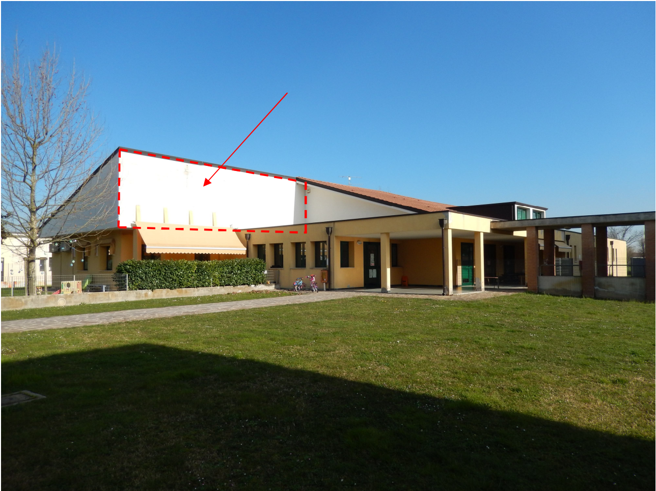
Figura 96: parete oggetto di verifica
