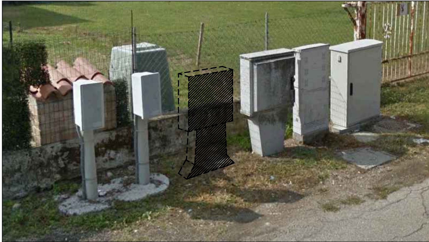
POSIZIONAMENTO QUADRO ELETTRICO VIA AMENDOLA
