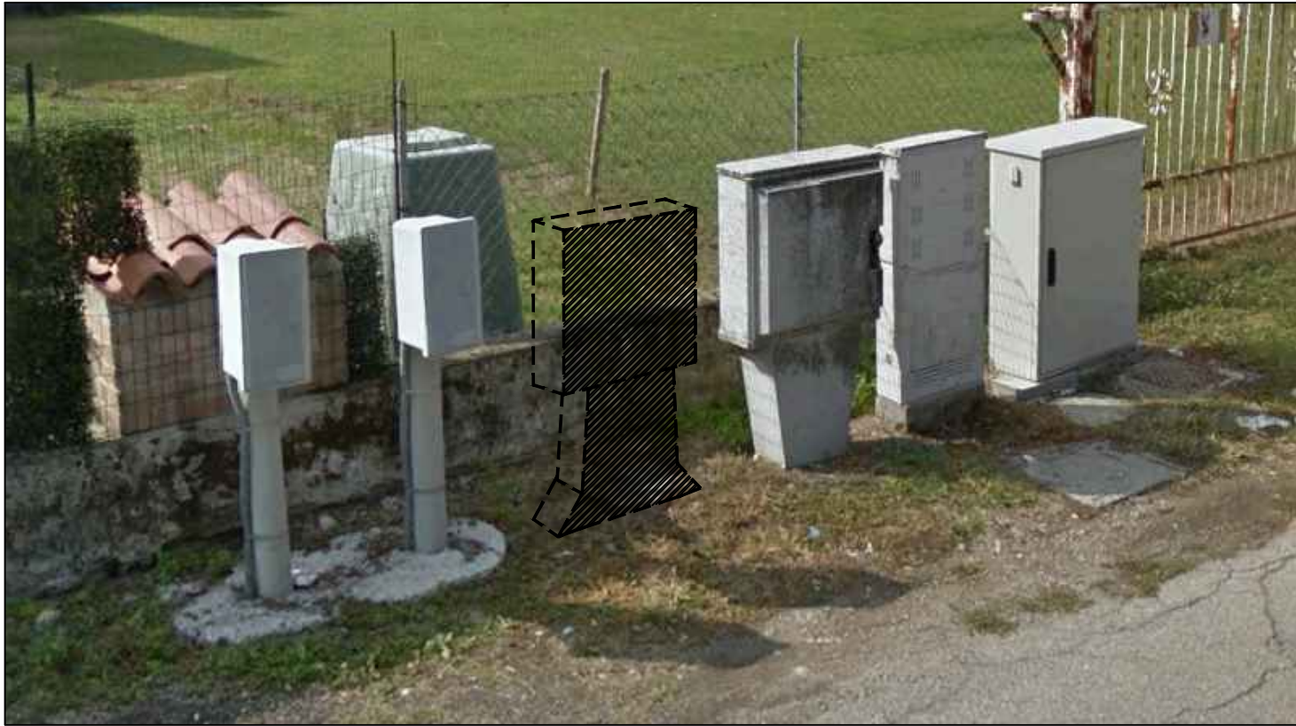
POSIZIONAMENTO QUADRO ELETTRICO VIA AMENDOLA
