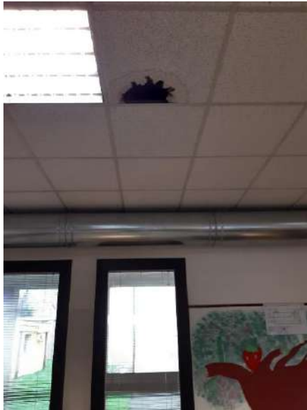
Danneggiamento struttura interna dovuta alle infiltrazioni da tetto
