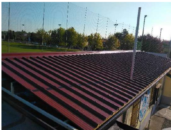
Esempio d'intervento già realizzato
