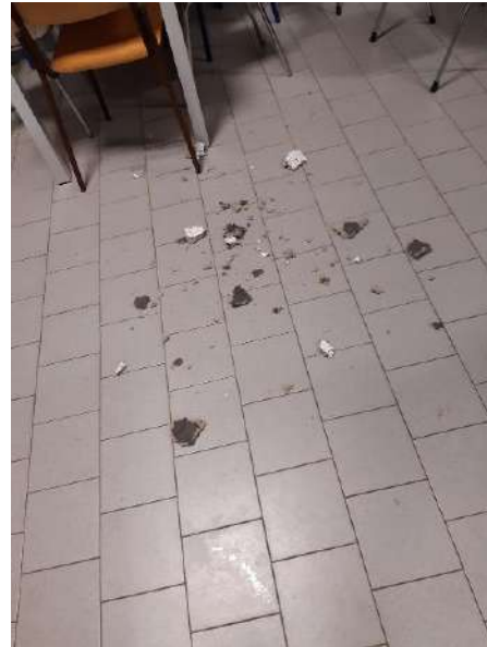
Danneggiamento struttura interna dovuta alle infiltrazioni da tetto
