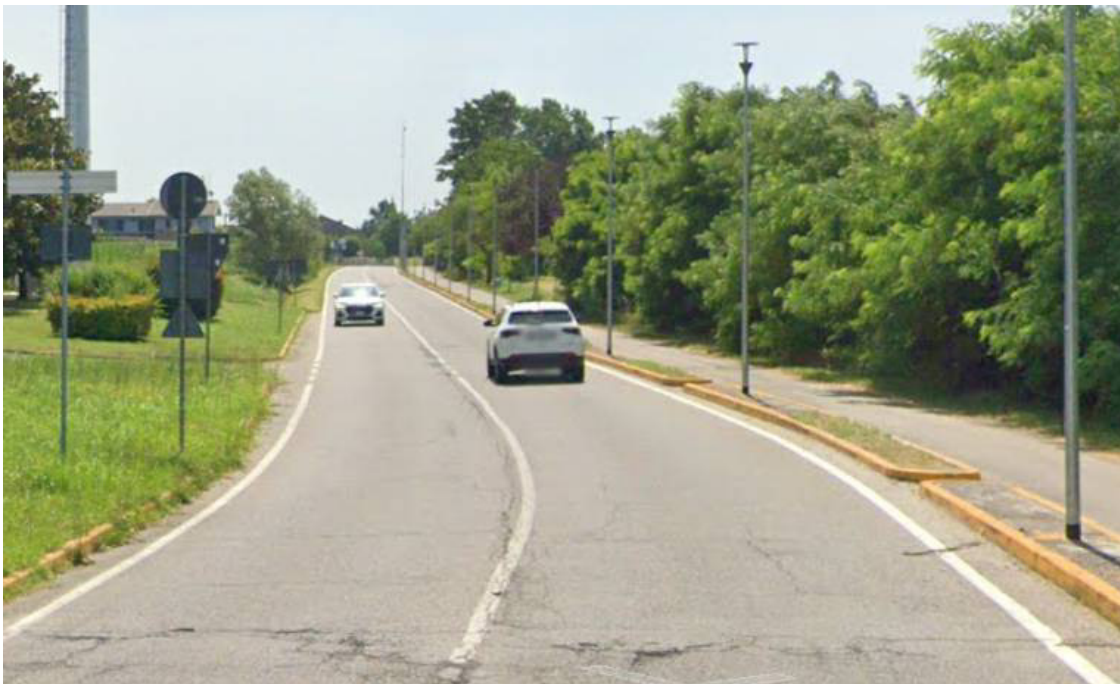
Via Levata – tratto tra via Pisacane e il Cimitero Comunale
