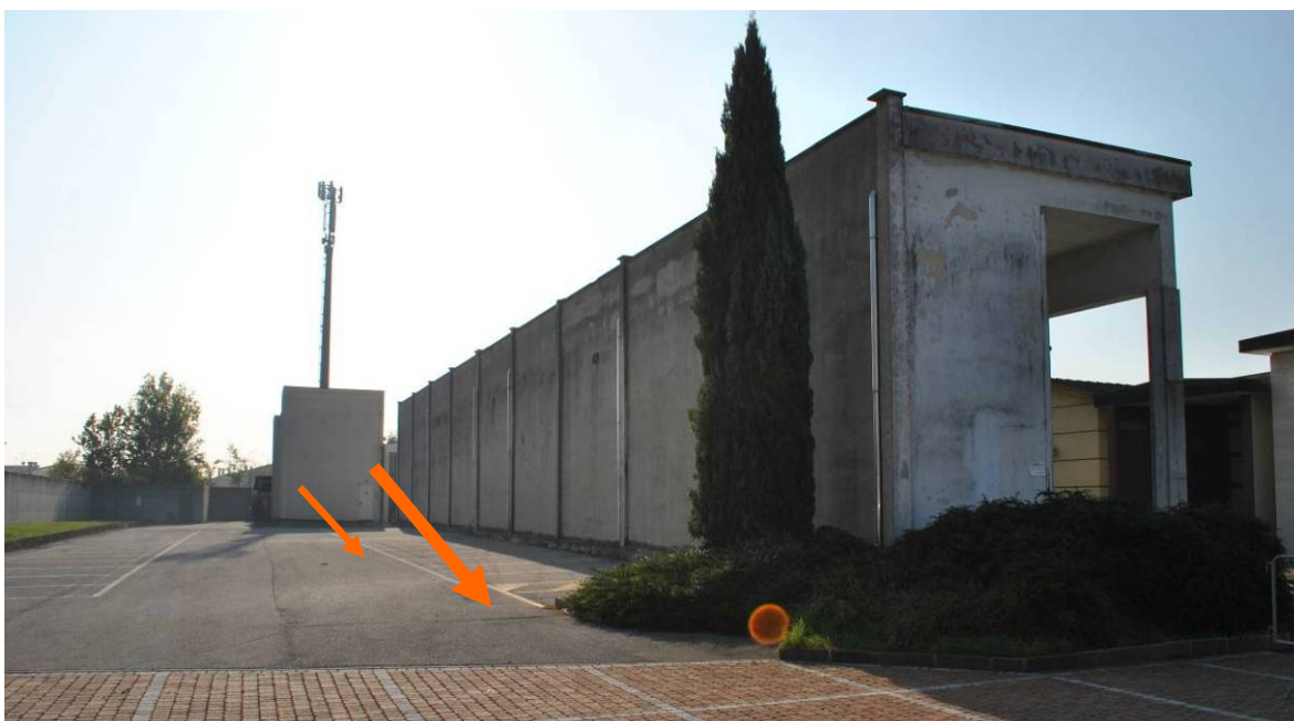
Foto n°8b. Vista della zona individuata per l'attuazione della seconda galleria programmata con il presente intervento (vedi frecce).
