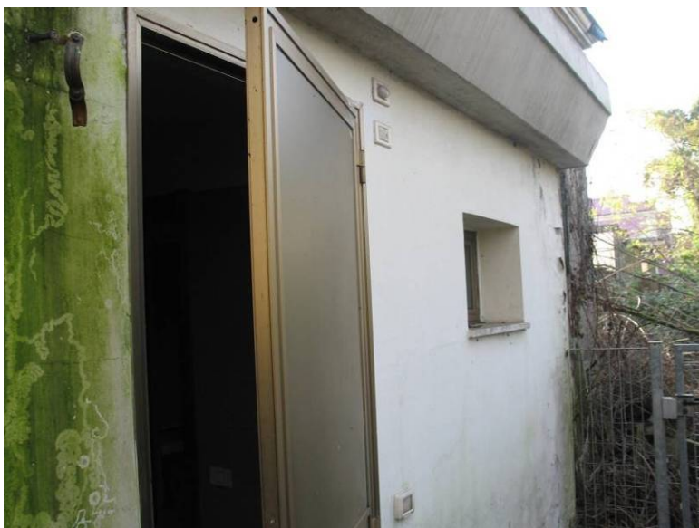
Foto 2c. e 2d .Le inquadrature evidenziano l'attuale stato manutentivo e l'attuale livello di finitura e rotazionale dei vani
