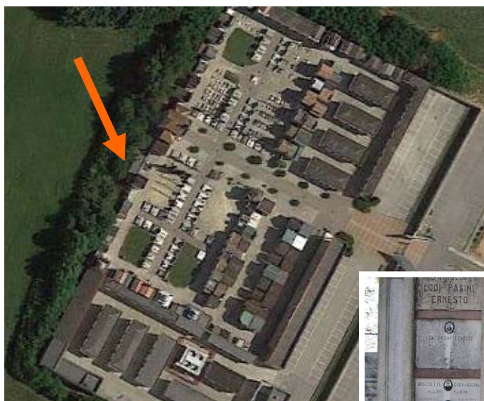
Foto 2a. e 2b. Individuazione dell'area di intervento ricavata esternamente al perimetro cimiteriale originario si accede attraverso il portoncino metallico visibile in foto sottostante
