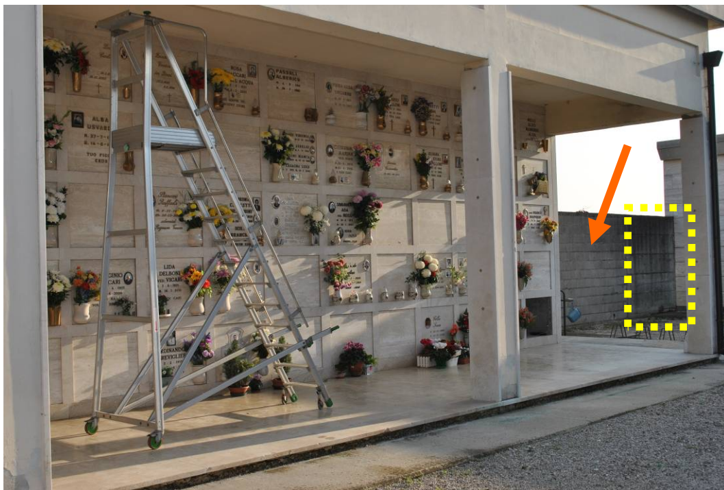
Foto 1b. Vista della galleria est verso sud; con freccia è indicata l'area ove si intende collocare il nuovo manufatto destinato a deposito mortuario; con tratteggio giallo è individuata la zona ove realizzare il nuovo accesso secondario.
